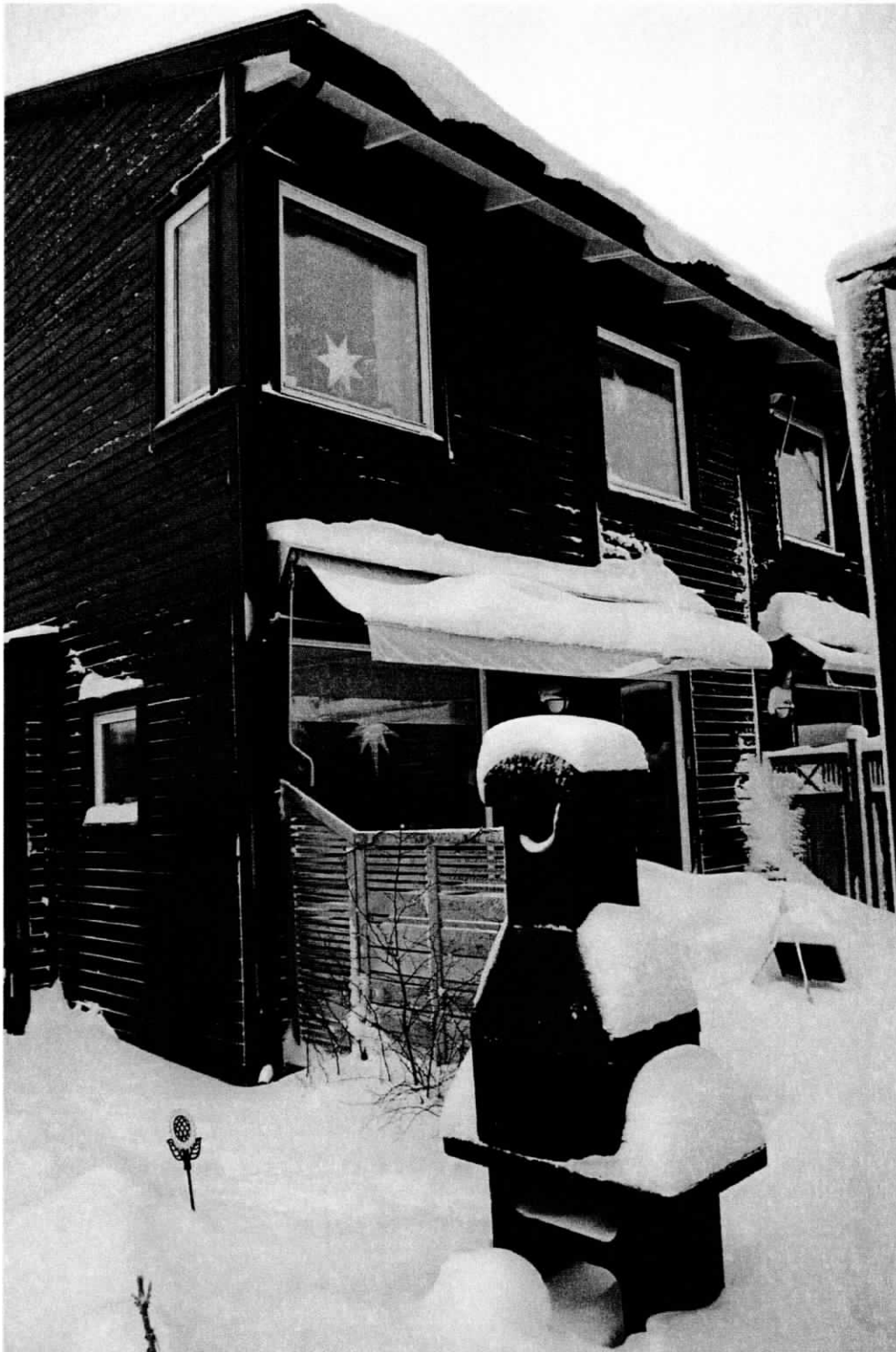
Baksida med uteplats i västerläge.
